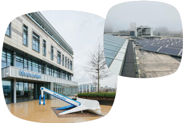
Immeuble BLUE WATER Bureaux - Pays Bas
